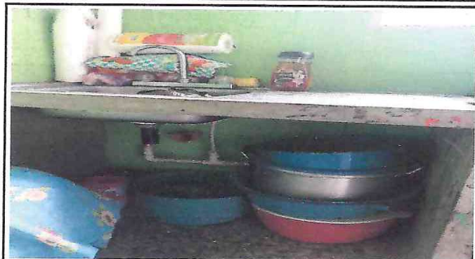
Foto 1: La cocina se encuentra con deficiencias en lavar trastos, tubería, falta de superficies para preparar los alimentos.
